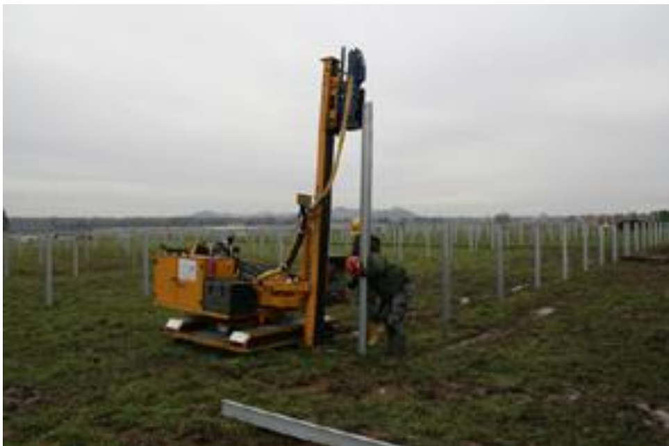
Zdjęcie 5 Montaż profili na potrzeby realizacji farmy fotowoltaicznej.
