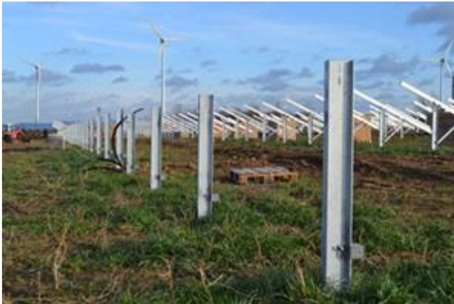
Zdjęcie 4 Profile metalowe: podstawowy element konstrukcji.
